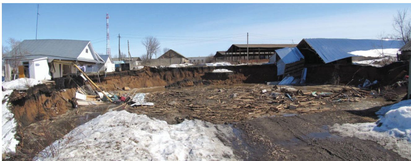
Рис. 1. Карстовый провал в р.п. Бутурлино Нижегородской области (апрель 2013 г.)
