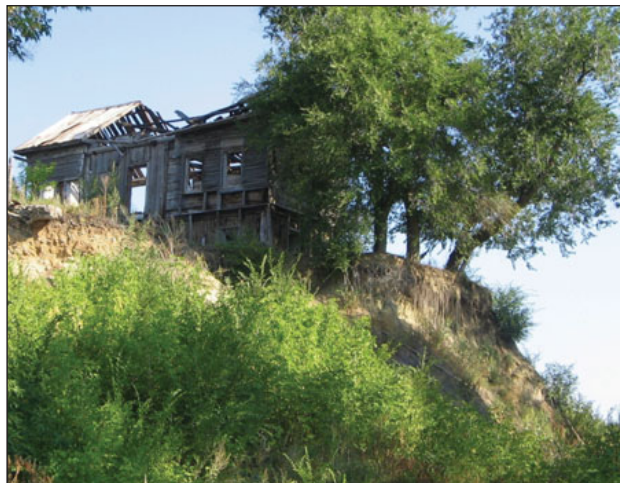
Рис. 5. Разрушение дома на северо-западном фланге оползня «Городской» (2007 г.)
