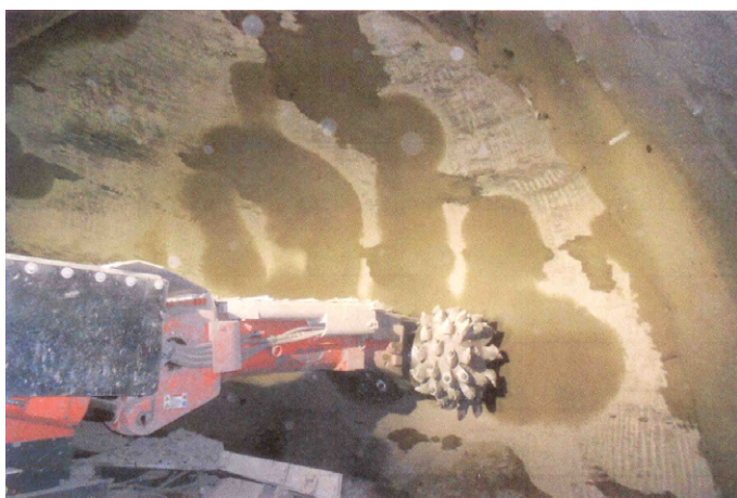
Рис. 1. Проходка железнодорожного тоннеля № 6-бис осуществлялась типовым горным способом стреловыми проходческими комбайнами с погрузкой грунта в подземные автопоезда МоА3
