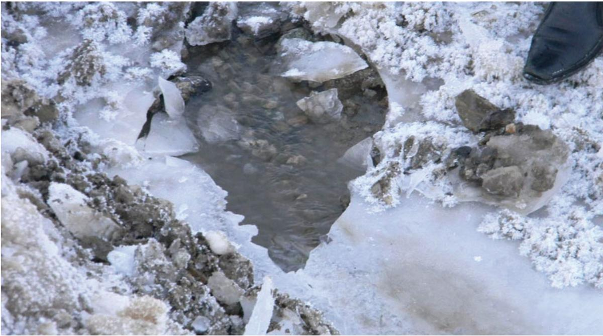
Рис. 8. Водоприток по водоотводной канаве 15.01.2011 г. при температуре наружного воздуха минус 40 °С
