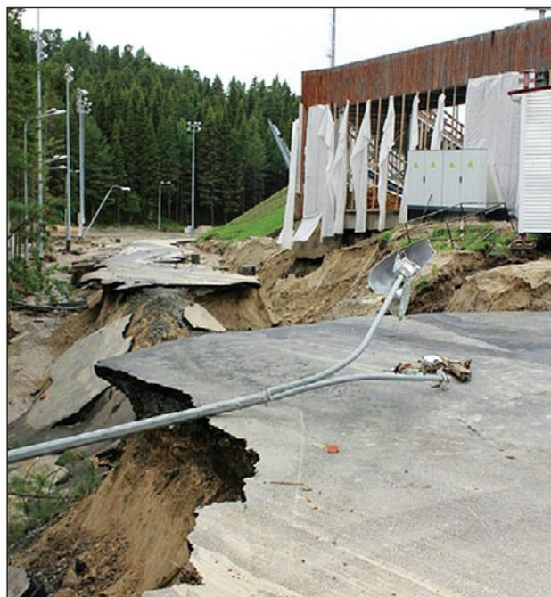
Рис. 2. Разрушения на биатлонной трассе (вид на трибуны)
