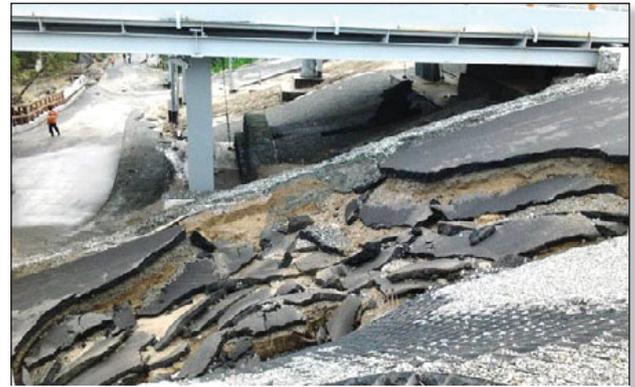
Рис. 3. Разрушения на скоростном спуске биатлонной трассы
