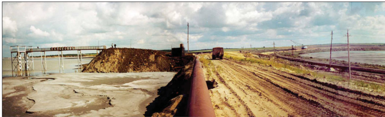
Рис. 6. Сброс пульпы в хвостохранилище Лебединского горно-обогатительного комбината
