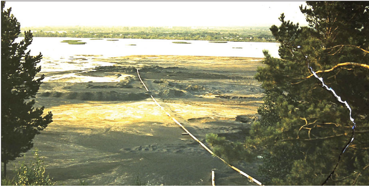
Рис. 2. Пульпопровод Назаровской ГРЭС. Золоотвал пойменного типа, расположенный в пойме реки Чулым
