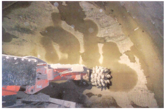
Рис. 1. Проходка железнодорожного тоннеля № 6-бис осуществлялась типовым горным способом стреловыми проходческими комбайнами с погрузкой грунта в подземные автопоезда МоАЗ
