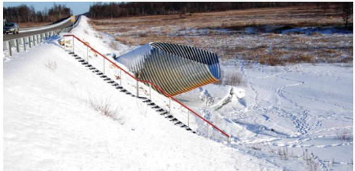
Рис. 2. Деформированная водопропускная труба на участке «км 526» автодороги «Амур» (25 декабря 2012 г.)
