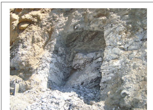
Рис. 4. Обрушенная призма со сформировавшейся очень сложной поверхностью обрушения
