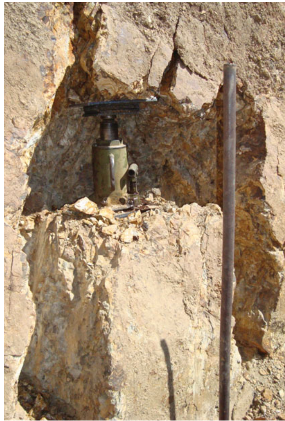
Рис. 5. Разрушение налегающего массива при испытаниях методом разрушения призм
