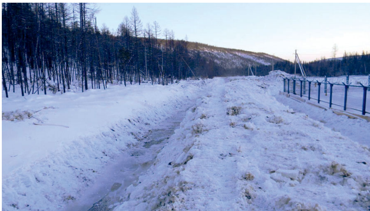
Рис. 4. Наледь грунтовых вод и водоотводная канава (январь 2011 г.)
