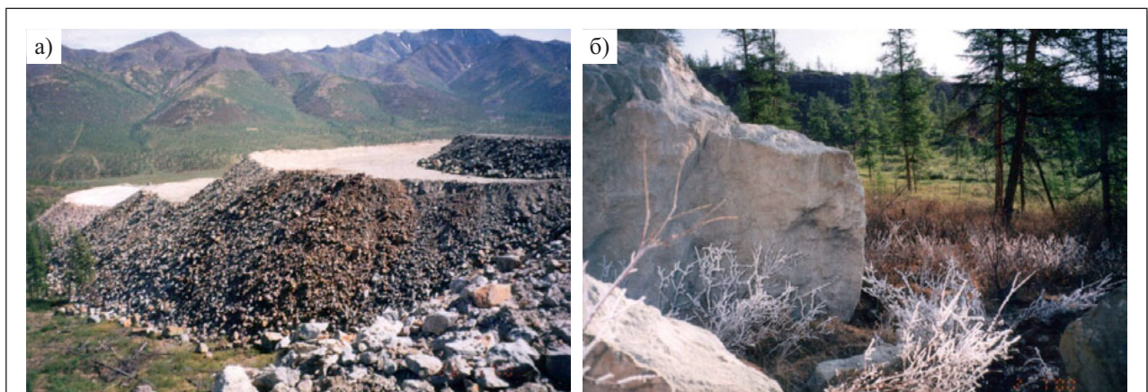
Рис. 6. Элементы отвала № 670 полигона Восточный: а — общий боковой откос и террасированные боковые бермы; б — сложенная крупными глыбами краевая часть фронтального откоса и примыкающая зона угнетенной вегетации
