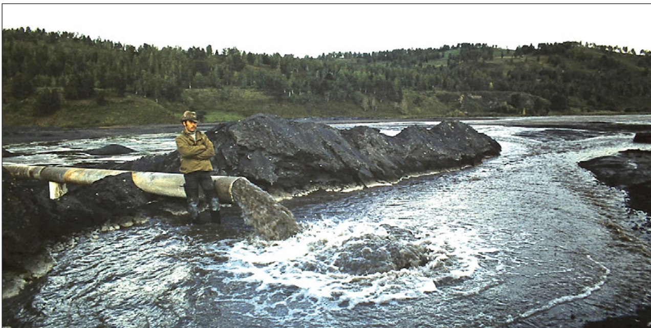
Рис. 3. Сброс пульпы в золошлакоотвал
