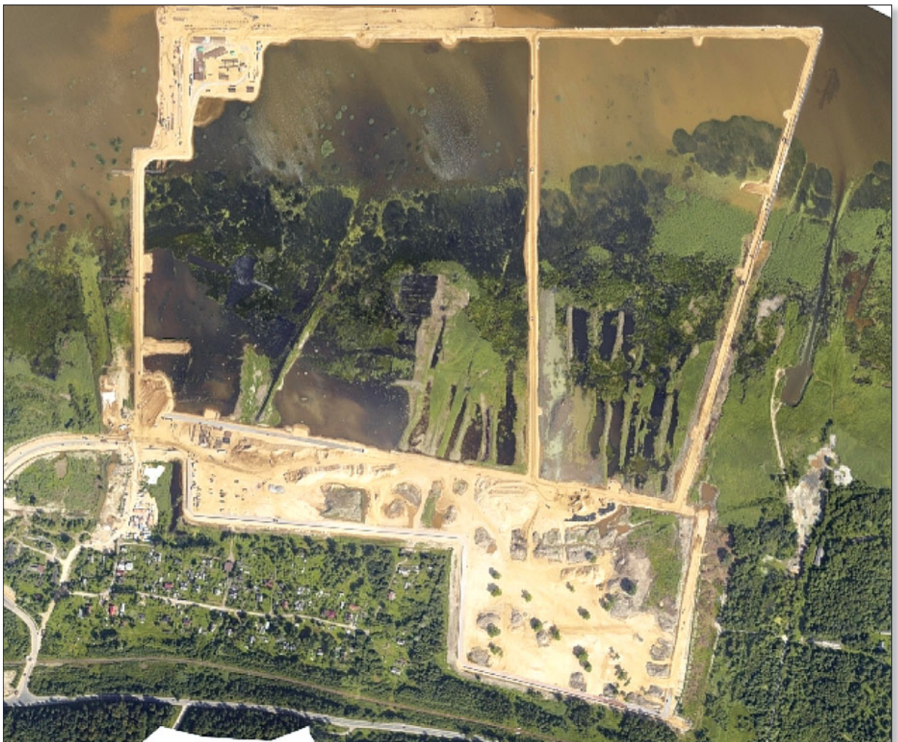
Рис. 5. Создание намывных площадей в г. Санкт-Петербурге. Аэрофотоснимок
