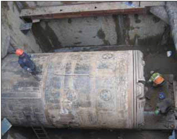
Рис. 1. Демонтаж щита фирмы Herrenknecht при строительстве кабельного коллектора в городе Реутове
