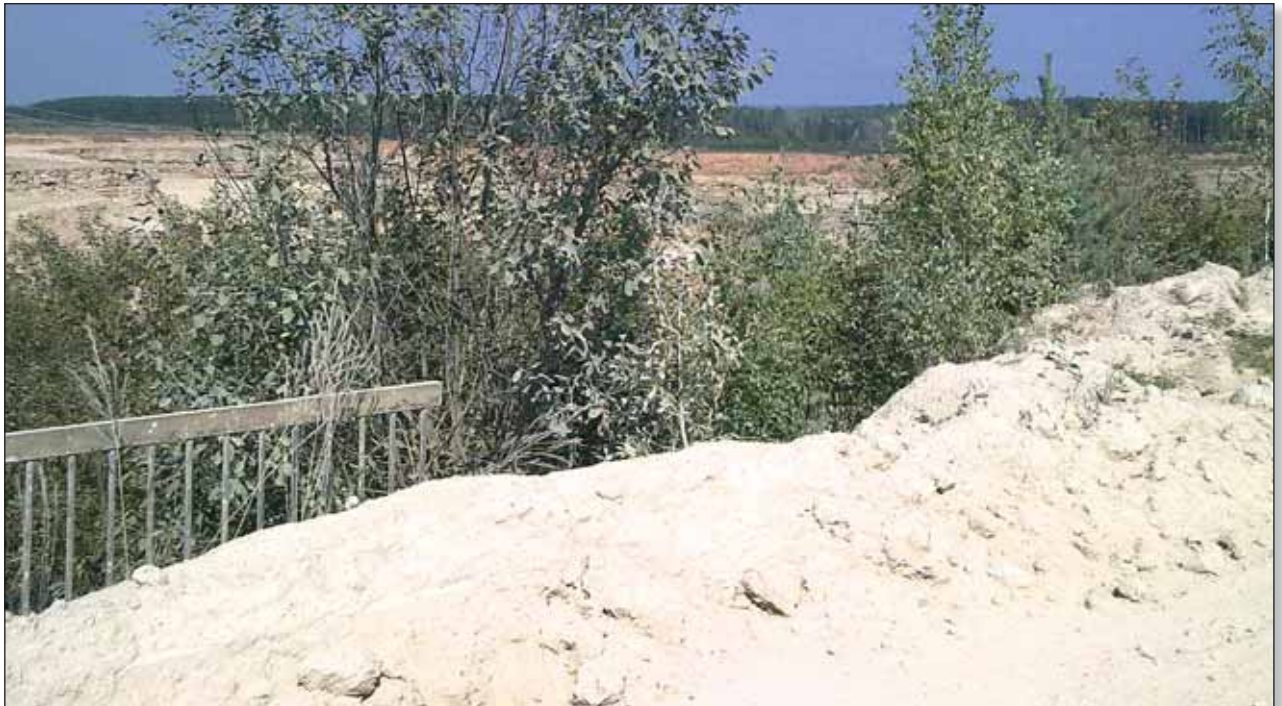
Рис. 7. Обочина технологической дороги карьера с «новообразованиями» из многолетней известняковой пыли (на втором плане — решетка ограждения моста путепровода)
