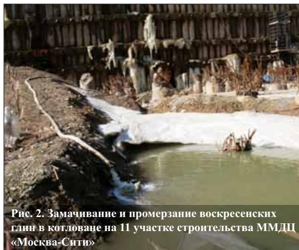
Рис. 2. Замачивание и промерзание воскресенских глин в котловане на 11 участке строительства ММДЦ «Москва-Сити»
