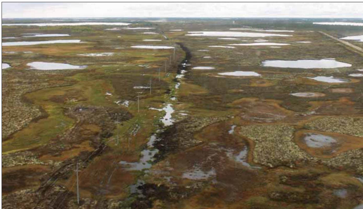
Рис. 5. Подтопление трассы «горячего» трубопровода при ее прохождении через массив многолетнемерзлых выпуклых бугров пучения (пальза) в лесотундровой зоне Западной Сибири (Пур-Тазовское междуречье, близ р. Туймылькы (фото из архива ОАО «ВНИИСТ»))
