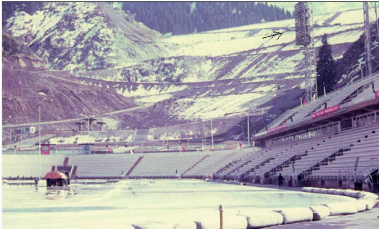
**Рис. 1. Плотина Медео, остановившая катастрофический сель 1973 г. Снимок сделан с трибуны катка Медео в начале апреля 1977 г.: в горах еще лежит снег, низкая облачность. На плотине начаты работы по ее реконструкции — наращивание высоты и прокладка новой системы водосбросов. Стрелкой отмечено кафе «Ласточка», которое в 1973 г. находилось на верхнем уровне плотины. Слева от плотины видны оголенные склоны — следы направленного взрыва 1966 г. (фото В.С. Шibaковой)**
