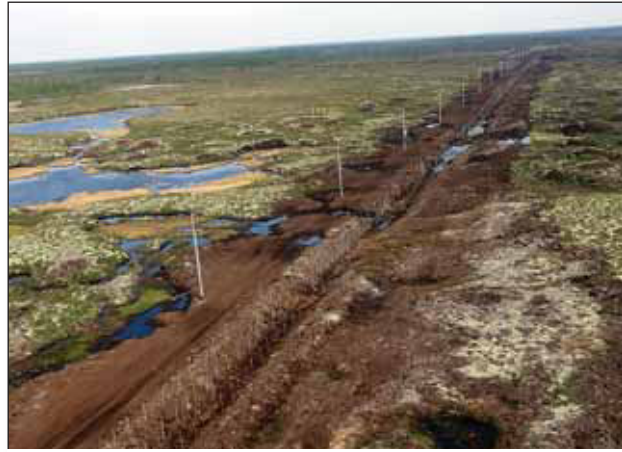
Рис. 8. Проявления термокарста вдоль трассы «горячего» нефтепровода. Термокарстовые воронки, отмеченные на месте протаявших бугров пучения, маркируют боковую границу ореола протаивания вдоль трассы (лесотундровая зона Западной Сибири, Пур-Тазовское междуречье близ реки Айваседа-Пур) (фото из архива ОАО «ВНИИСТ»)
