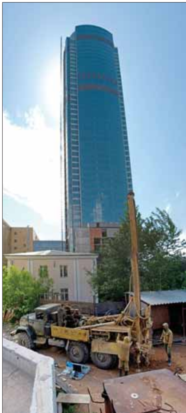
Рис. 1. Здание блока Е многофункционального высотного комплекса «Антей»
