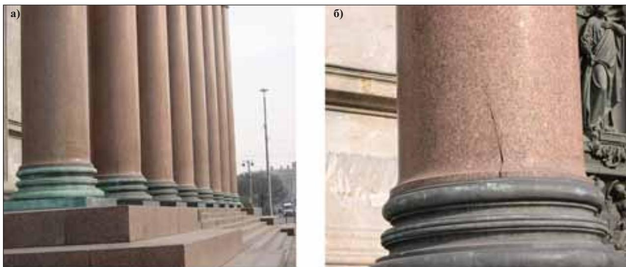
Рис. 2. Трещины скола в нижней части колонн западного портика Исаакиевского собора
