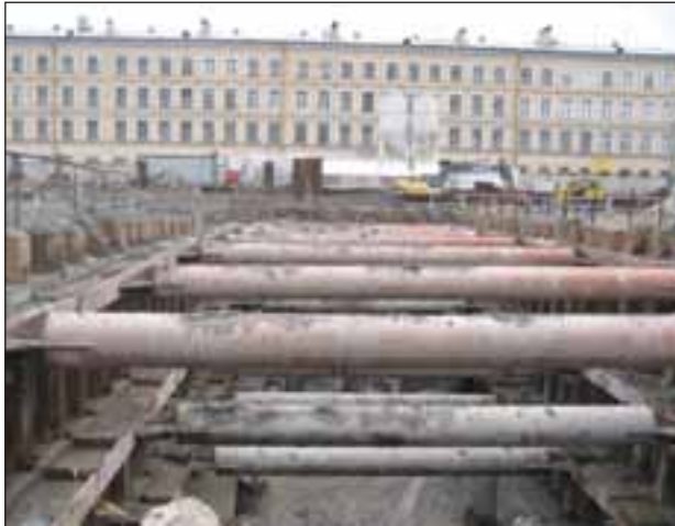
Рис. 2. Общий вид опытной площадки на территории строительства второй сцены Мариинского театра
