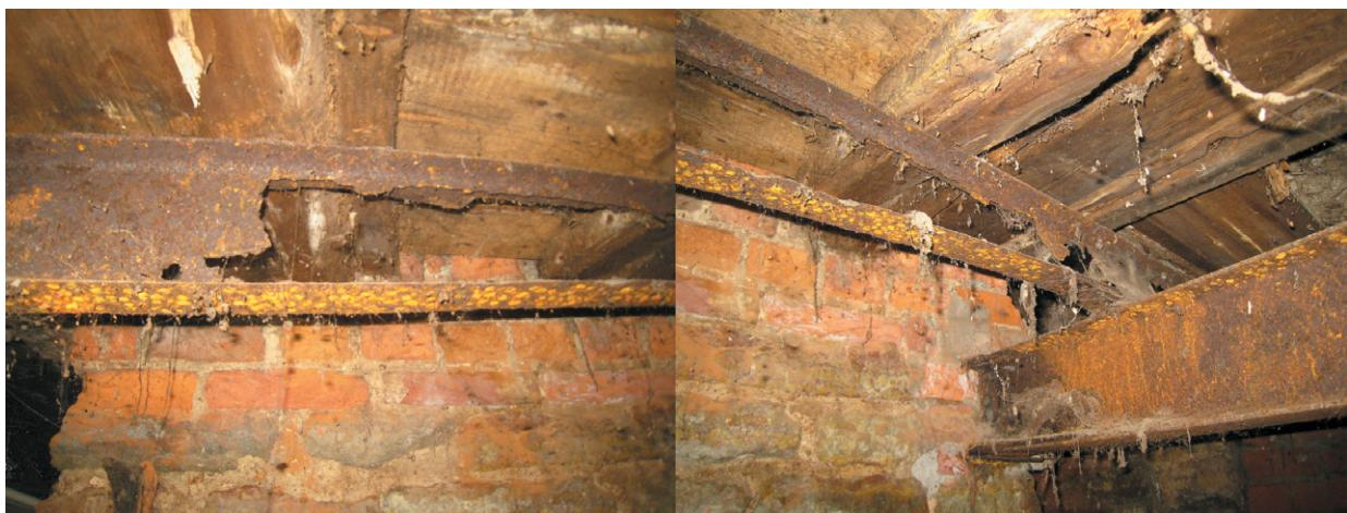
Рис. 2. Поражение древесины в подвальном помещении (образование бурой гнили)
