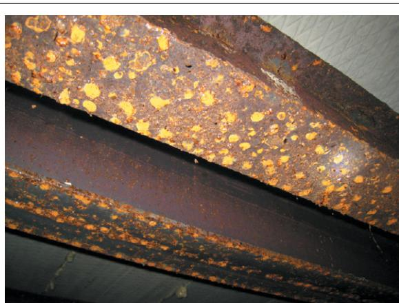
Рис. 6. Точечная коррозия металлической конструкции, обусловленная образованием конденсата. Начальная стадия развития «питтинга» (образование углублений)
