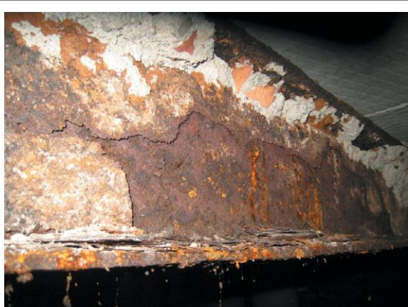
Рис. 5. Глубокая коррозия металлических конструкций. Наблюдается многослойное отслаивание и осыпание их фрагментов
