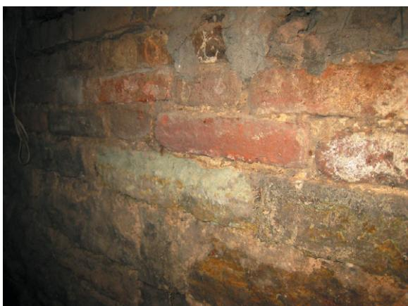
Рис. 4. Повреждение кирпичной кладки
