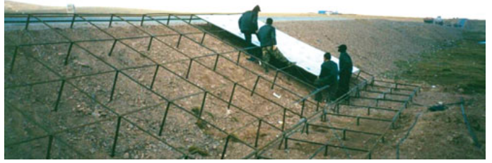
Рис. 3. Сооружение солнцезащитного навеса на Цинхай – Тибетском шоссе, сентябрь 2003 г.
