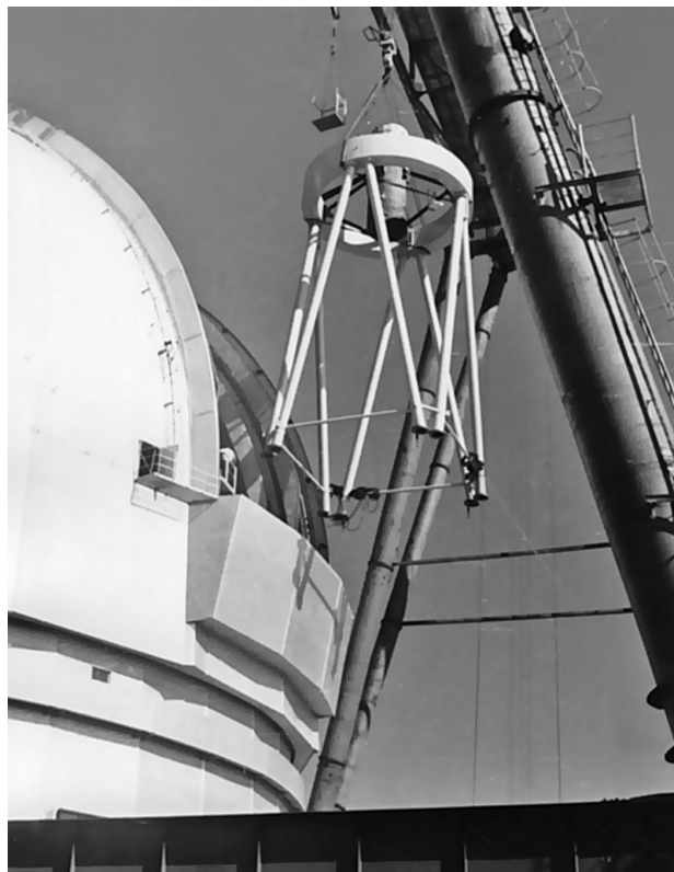
Монтаж верхней части трубы БТА с кабиной первичного фокуса в башню Обсерватории. Осень 1974 г.
