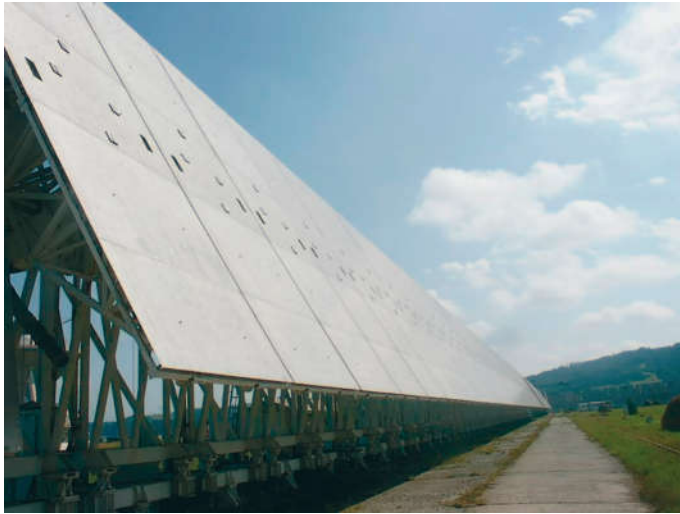
Перископическое зеркало на Южном секторе радиотелескопа РАТАН-600, состоящее из 124 отражательных элементов высотой 8,5 м и шириной 3,1 м каждое. Перископ протяженностью 400 м управляется по углу высоты и обзревает южную часть неба в диапазоне азимутальных углов – от + 30° до –30°.
