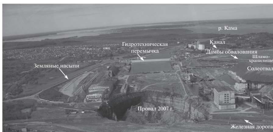
Рис. 2. Инженерные сооружения в долине р. Кама на площади калийного рудника СБ ГПА.
