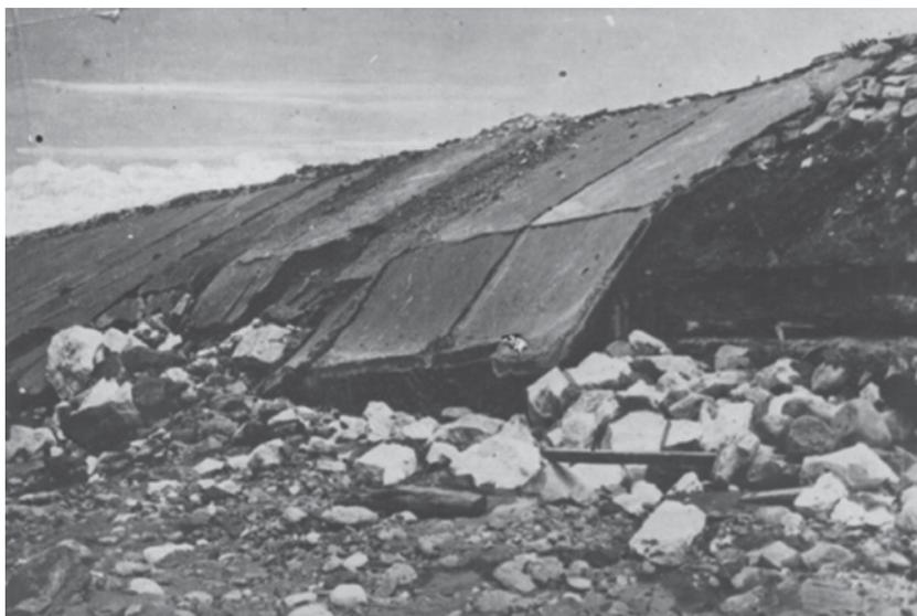
**Рис. 5.** Неправильно подобранные и возведенные берегоукрепительные сооружения на р. Слюдянка, разрушенные селевым потоком в 1960 г.
