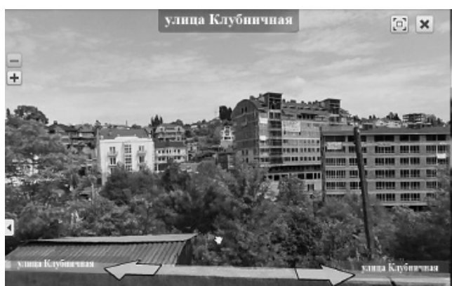
Рис. 6. Новостройки г. Б. Сочи; класс уязвимости зданий С7–С9 по шкале ММСК-86.
