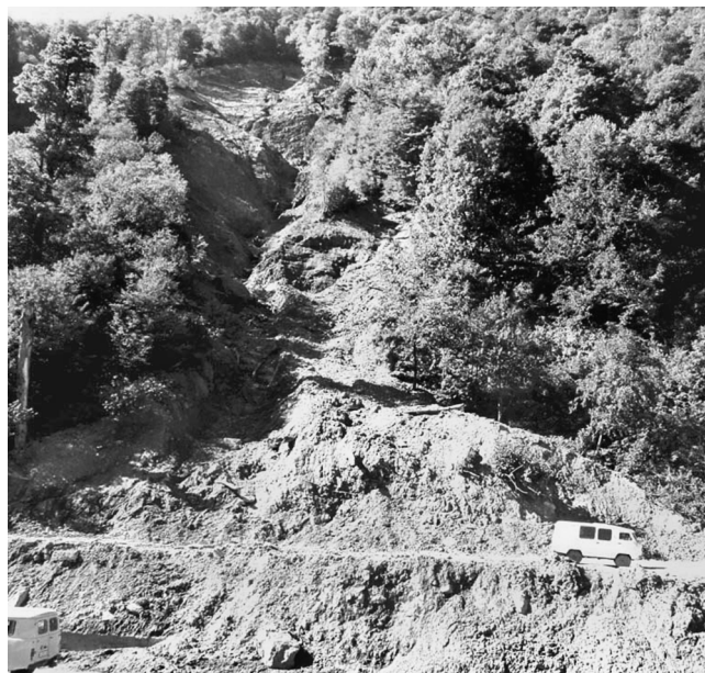
Рис. 1. Техногенно-обусловленный селевой врез ПС-8 и его конус выноса. Технологическая автодорога к подстанции ФСК “Мзымта”.
