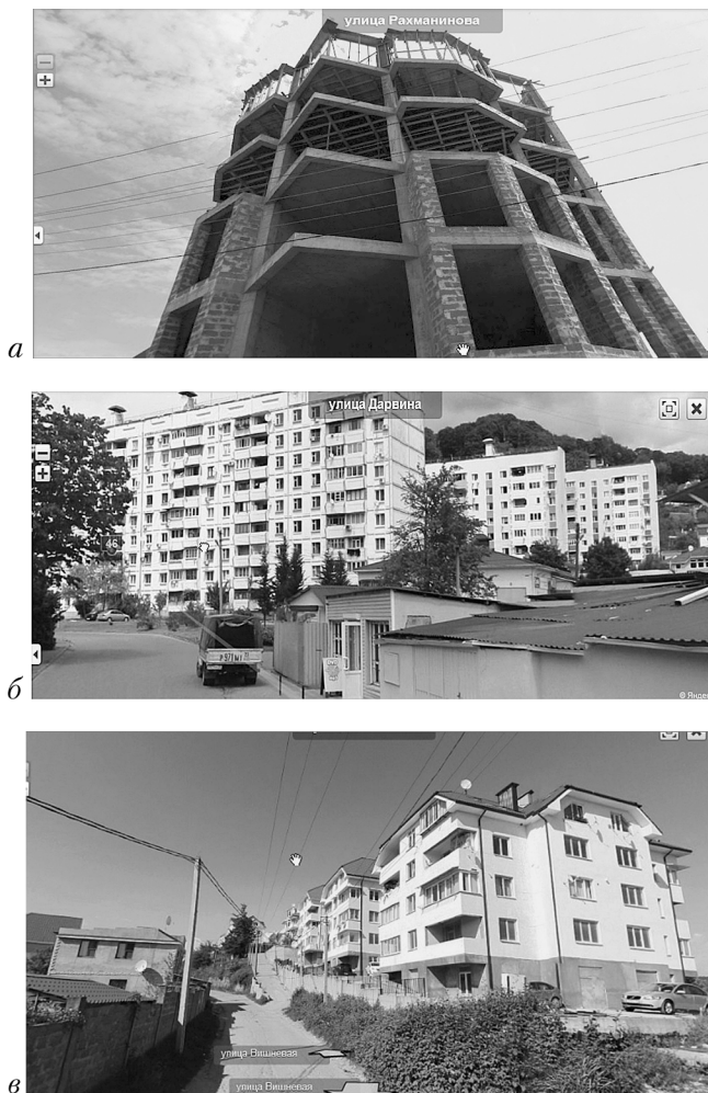
Рис. 9. Типичный каркас сейсмостойких новостроек в г. Б. Сочи (а); жилые дома: из крупных панелей в квартале 31 (б) и с несущим железобетонным каркасом в квартале 65 (в). Класс уязвимости С7-С9.
