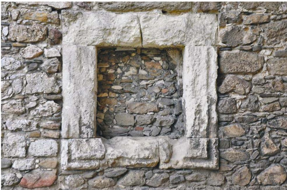
**Рис. 9.** Разбитые трещинами каменные блоки подоконника и оконного перекрытия в восточной стене большой комнаты южного айвана медресе Инджи-бей-хатун с заложеным камнями для укрепления этой части поврежденной стены внутренним пространством оконного проема
