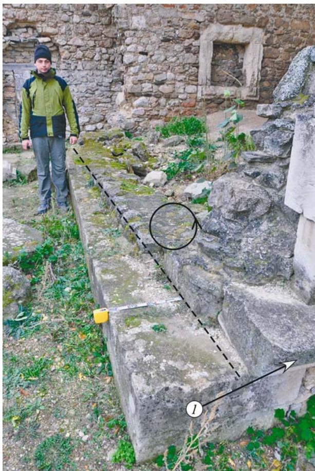
**Рис. 10.** Разворот против часовой стрелки на  $10^\circ$  значительного фрагмента сооружения – северо-западного угла большого помещения в южной анфиладе комнат медресе Инджи-бей-хатун
