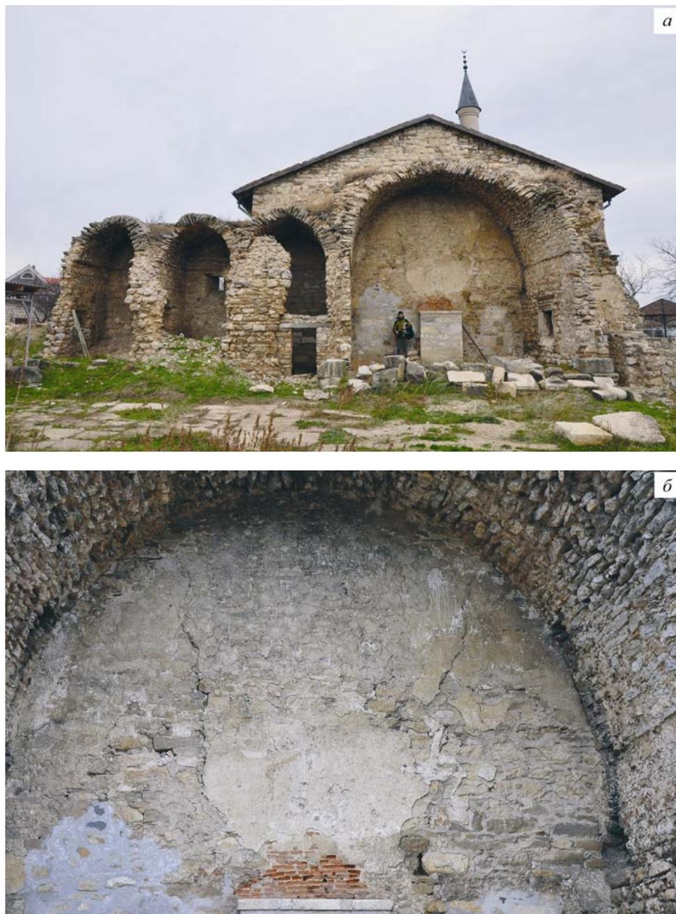
**Рис. 8.** Значительные межблоковые трещины в большом помещении северного айвана медресе Инджибей-хатун
