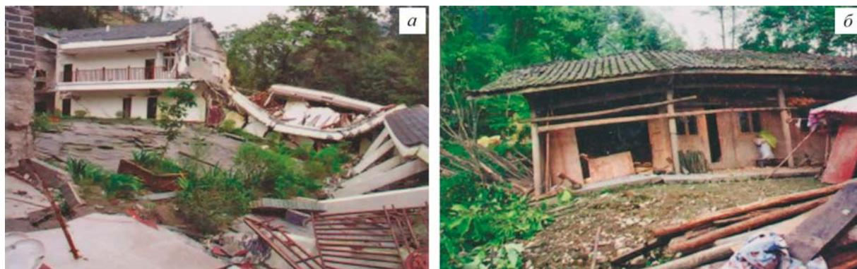
**Рис. 9.** Примеры разрушения зданий при Веньчуаньском землетрясении. Фото Сюй Сивэй
