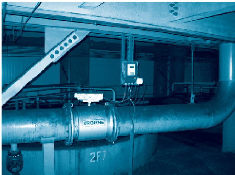
**Рис. 2.** Измерение расхода сточных вод в частично заполненном трубопроводе DN 400 с использованием TIDAFLUX 4110PE.
