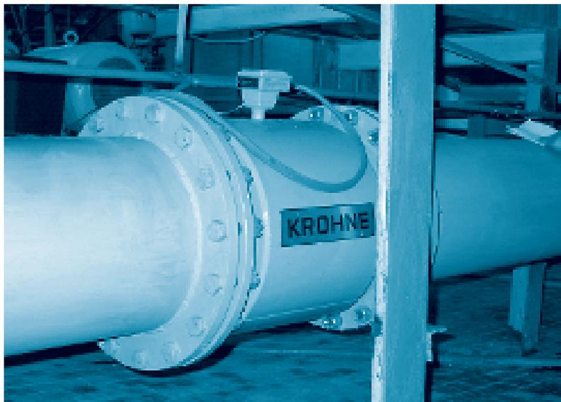
**Рис. 1.** Электромагнитный расходомер OPTIFLUX в системе водоснабжения г. Тобольска.
