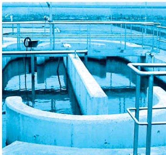
предназначенным для локальной очистки городского поверхностного стока от плавающего мусора, взвешенных веществ и нефтепродуктов. Проектом этих сооружений предусмотрена многоступенчатая схема очистки (рис. 1).
