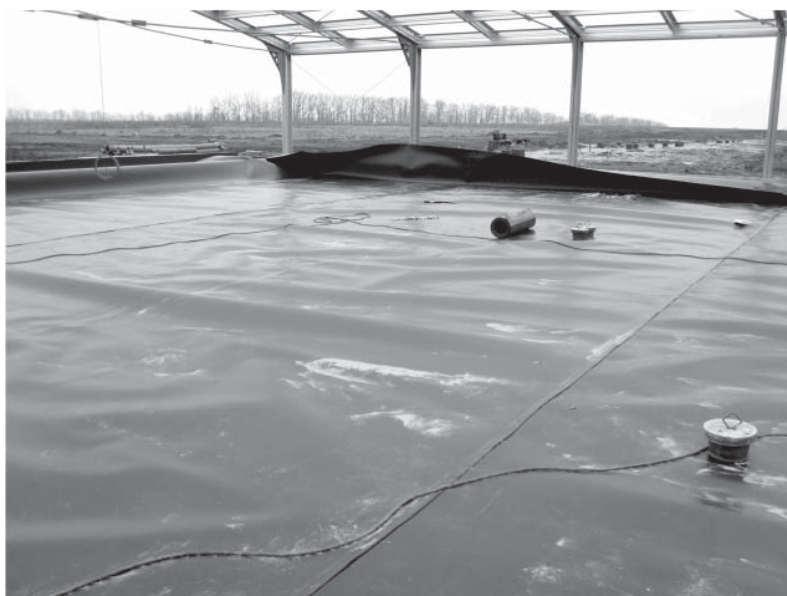
Рис. 2. Гидроизоляционный ковер как единое целое по всей поверхности навозосборника.
