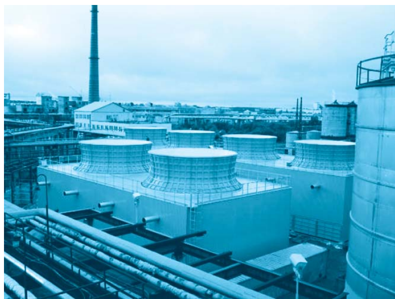
Рис. 7. Вентиляторная градирня.
