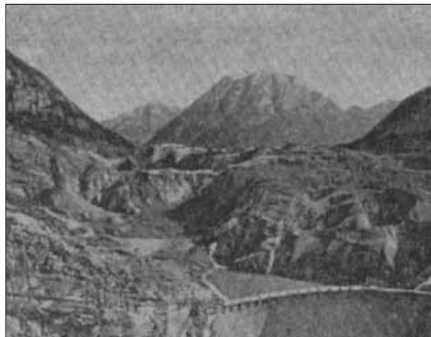
Рис. 6. Плотина и левый склон долины реки Вайонт после катастрофы
